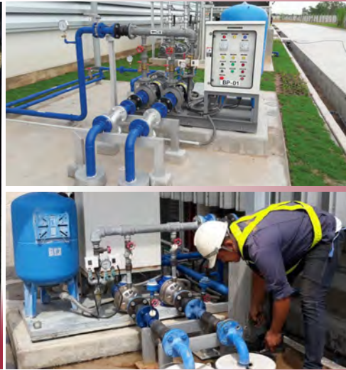
ติดตั้งระบบ Booster Pump
