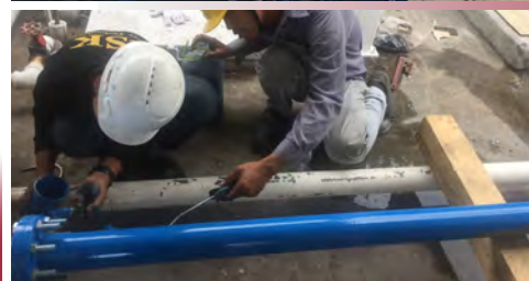
ปรับปรุงระบบท่อน้ำและท่อน้ำดับเพลิง
