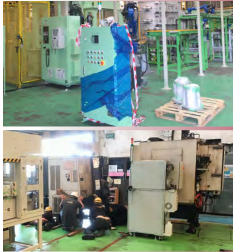
ย้ายและปรับปรุ่่งเครื่องจักร
